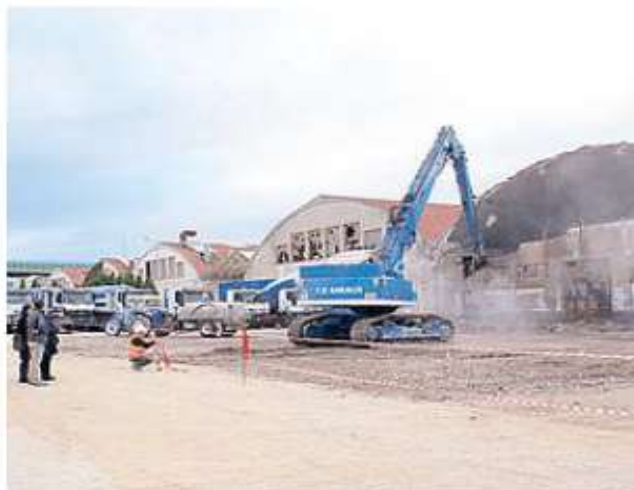
CANTIERE Le prime fasi di bonifica dell'ex Ceramica, nel novembre scorso
